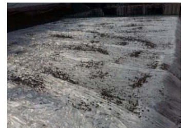
8. Finalizing with PE film
